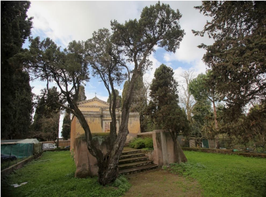
Pianabella, chiesa di S.Ercolano. Nelle immediate pertinenze insistono recinzioni, strutture in precario e superfetazioni che determinano una decontestualizzazione del bene relativamente all'area di "rispetto"
